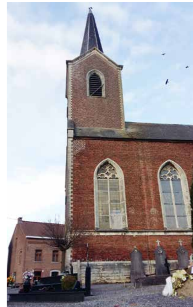
De kosten voor de renovatie van de St. Katherinakerk in Zuurbemde wordt geraamd op 700 000 euro.
